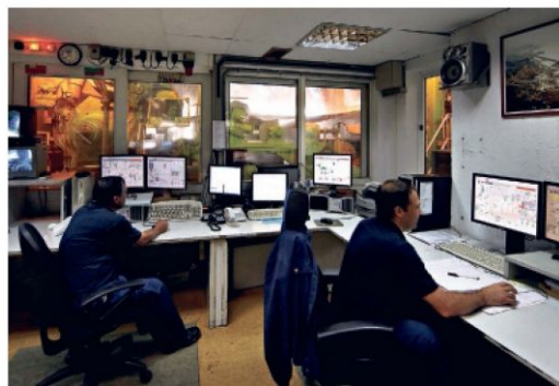
Centro de control de la fábrica de Ence en Pontevedra.
